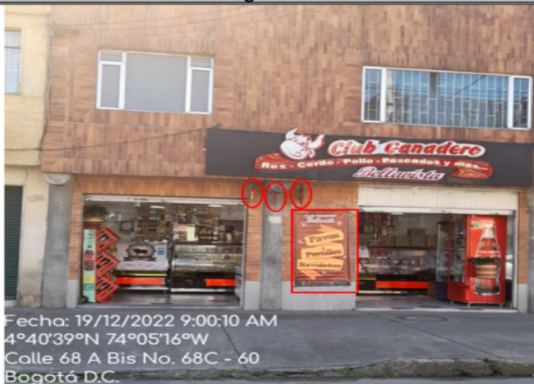
Fotografía panorámica en la cual se evidencia tres (3) elementos salientes de la fachada, un (1) elemento tipo pendón, adicional al elemento permitido se constituye que el establecimiento CLUB GANADERO BELLAVISTA cuenta con más de un aviso.
